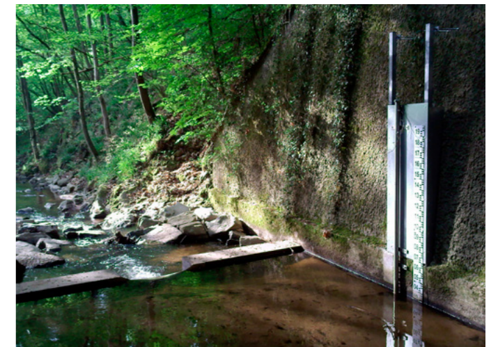
Figure 15a : Station hydrométrique sur le bassin-versant de l'Yzeron, © SAGYRC
